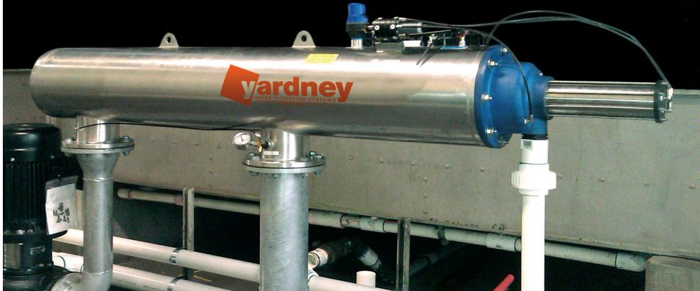
El cuerpo del filtro está fabricado en acero inoxidable reforzado que brinda resistencia a la corrosión en la mayoría de los climas.
